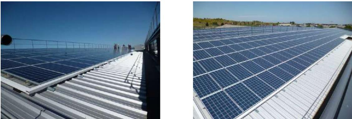
Figure 3 : Exemple de mise en œuvre d'une installation solaire suivant le système d'intégration proposé
