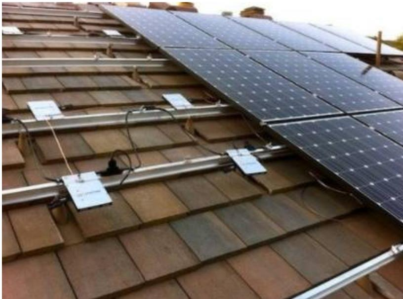
Figure 3 : Exemple de mise en œuvre d'une installation solaire suivant le système d'intégration proposé
