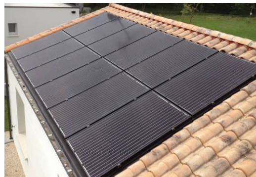
Figure 3 : Exemple de mise en œuvre d'une installation solaire suivant le système d'intégration proposé
